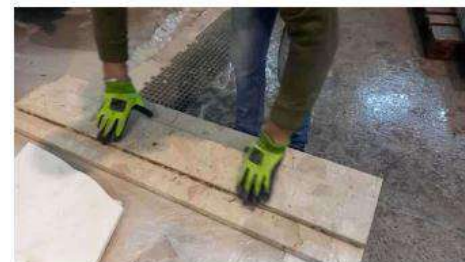
Marches après dépose et découpe
